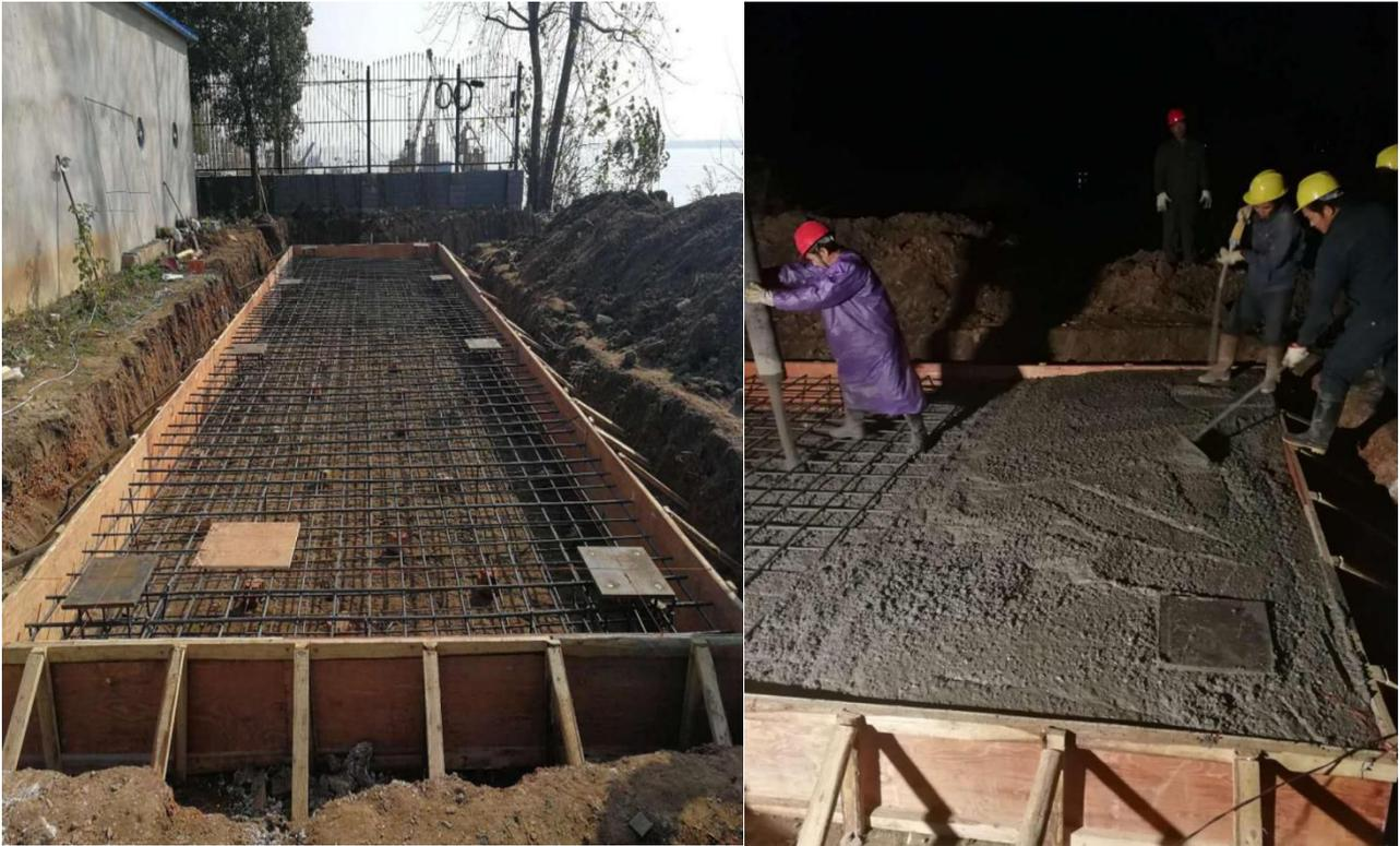
图 8-5-1 项目污水处理站防渗施工工程图
