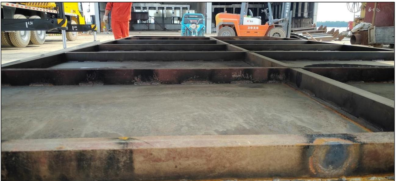
图 8-4-2 项目钢质危险废物暂存间底部的防渗漏托盘
