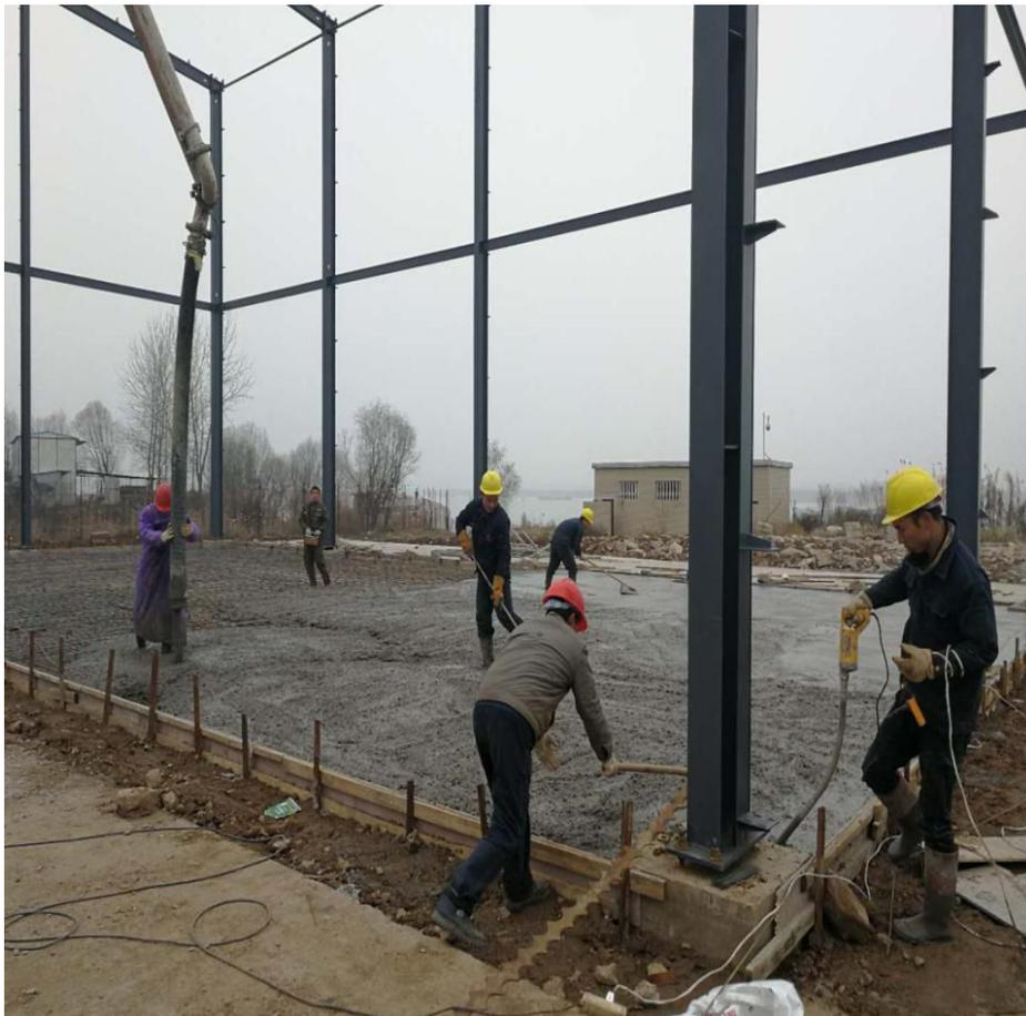
图 8-5-1 项目涂装间防渗施工工程图
